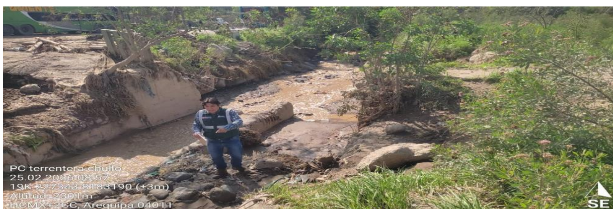
IMAGEN 02: SE MUESTRA LA EROSION DE LA QUEBRADA CHULLO QUE HA DESTRUIDO EL PUENTE AGUAS ARRIBA DEL PUNTO DE INICIO DEL TRAMO HASTA LA DESEMBOLCADA DEL RIO CHILI
