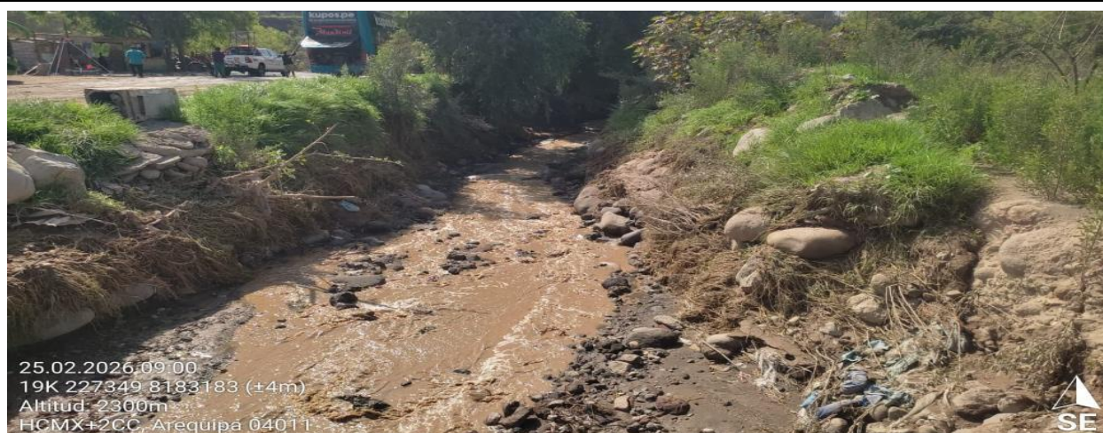
IMAGEN 01: SE MUESTRA EL ESTADO ACTUAL DEL CAUCE DE LA QUEBRADA CHULLO SE REQUIERE DE PROTECCION EN AMBAS MARGENES PARA EVITAR LA EROSION Y MITIGAR INUNDACIONES
